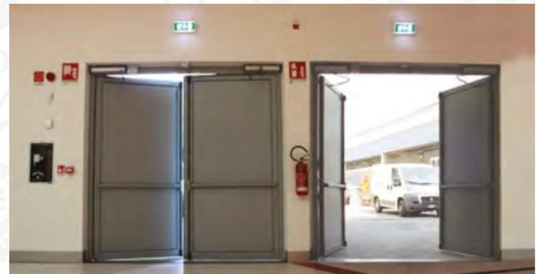
Porte automatiche a battente SDO con maniglie antipanico elettronico / Antipanic Swing Door Operator for escape route
